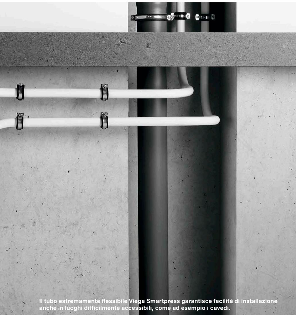
Il tubo estremamente flessibile Viega Smartpress garantisce facilità di installazione anche in luoghi difficilmente accessibili, come ad esempio i cavedi.
